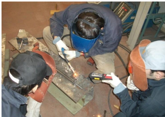
実習（アーク溶接）
